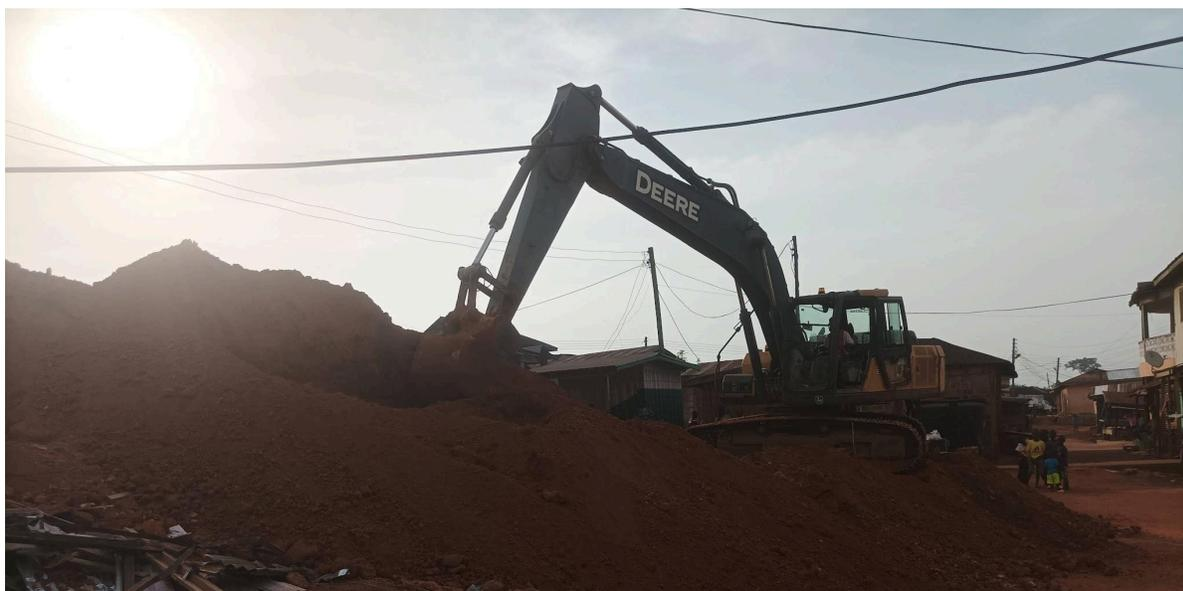
Die Beschaffung des richtigen Baggers zur Aushebung eines 120 Kubikmeter großen felsigen Lochs für die Biogasanlage erforderte umfangreiche Recherchen. Schließlich beschafften wir einen Bagger von einer Goldmine, 140 Kilometer entfernt. Der Transport auf das Plateau, das etwa 600 Meter über dem Meeresspiegel liegt, ist zwar komplex, aber notwendig.
